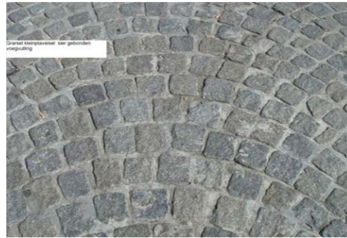
Nr 12+13: Bestrating type 3 Kleinplaveisel in gebonden voegvulling
